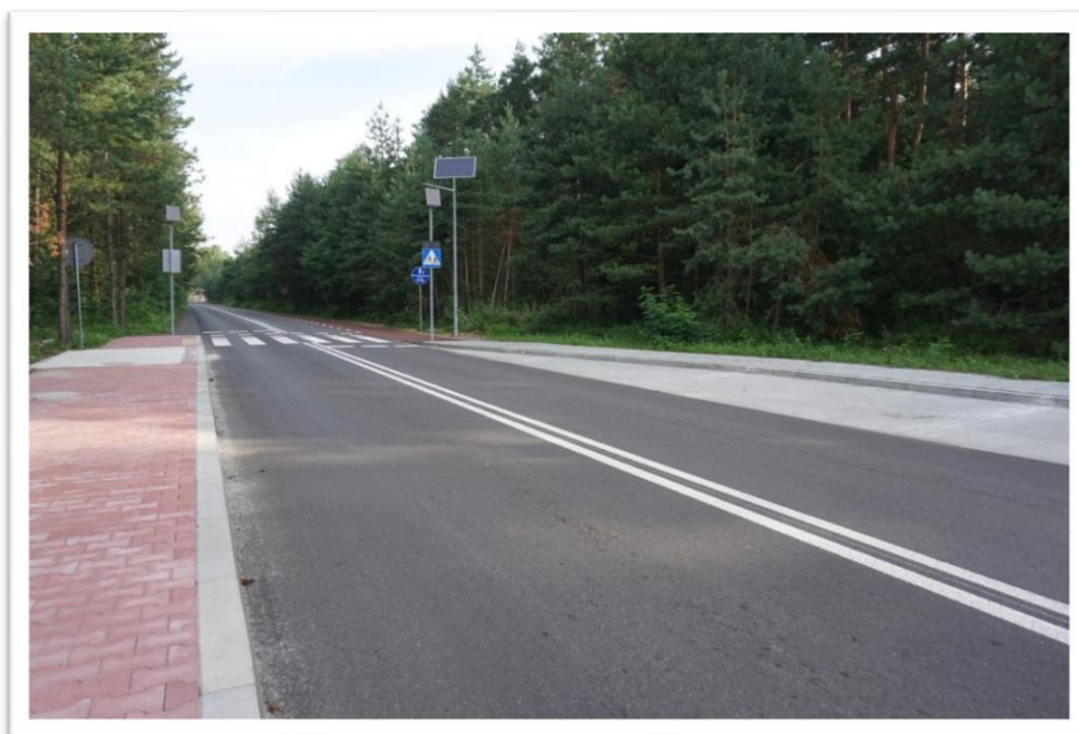
Przebudowa ul. Powstańców Styczniowych w Chrzanowie
