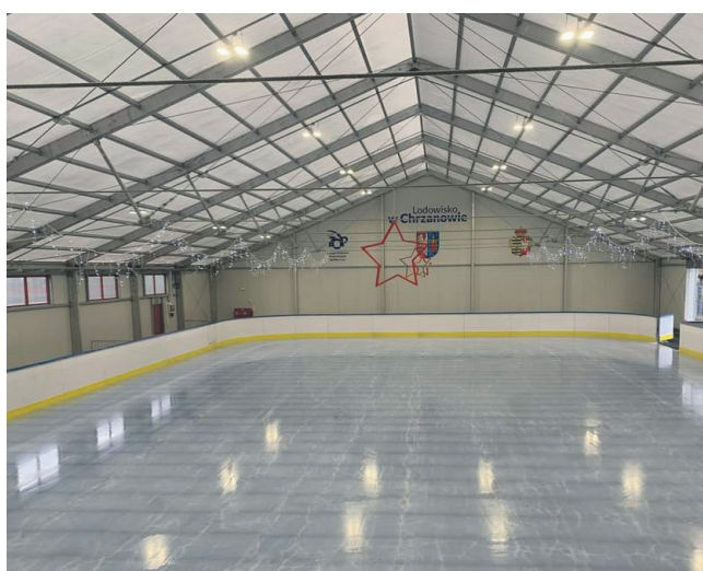
Zadaszone lodowisko w Chrzanowie
