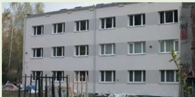
Fot. P. Sośnierz. Budynek ZST-U w Trzebini w trakcie termomodernizacji - już widać efekty
