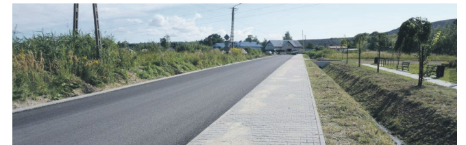
Przebudowa ulicy Dąbrowskiego w Libiążu
