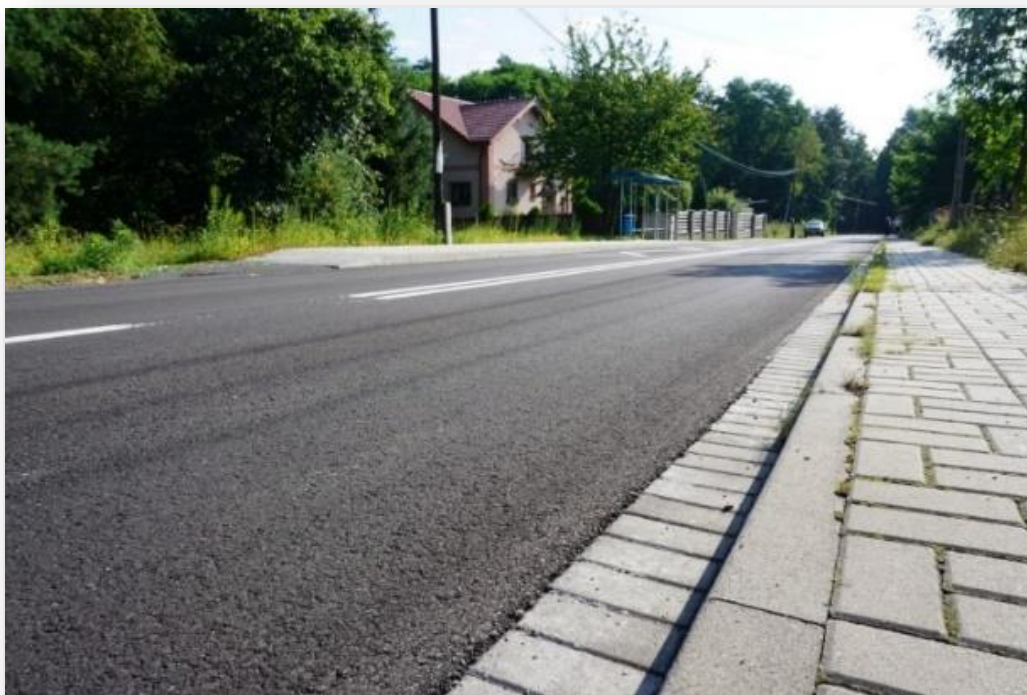
Przebudowa ul. Jaworowej w Libiążu
