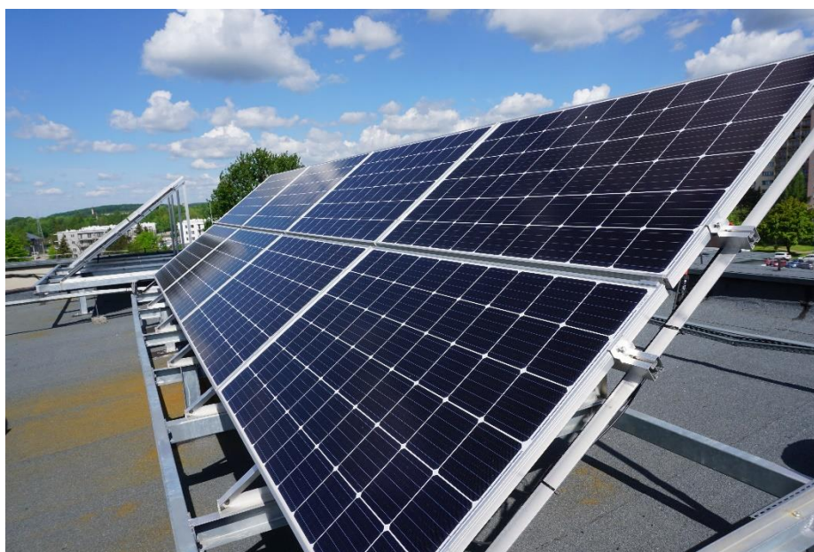
Fot. Panele fotowoltaiczne na budynku Starostwa przy ul. Partyzantów 2
